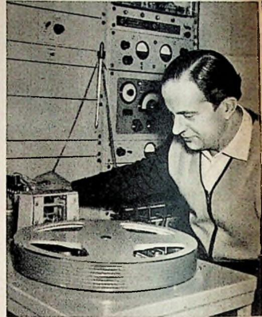
Pausenzeichengerät des RTI. Das Magnettonband ist spiralförmig auf einen Zylinder aufgewickelt. Der Hörkopf gleitet in einem fahrschuhartigen Schlitzen während der Umdrehungen des Tellers mit dem Magnettonband auf und ab (Aufn. dpa)
